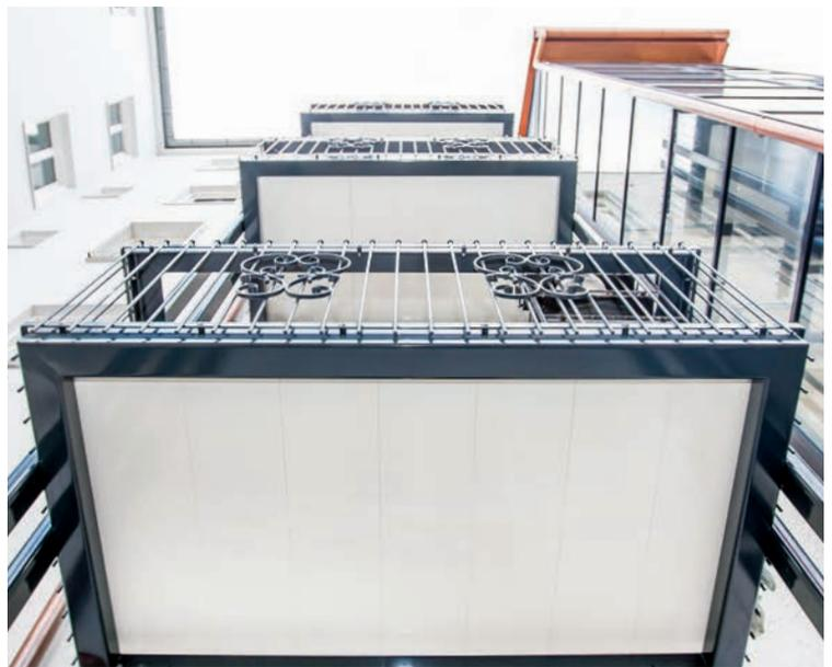
*Bei einer Balkontiefe bis ca. 2 m benötigt man somit auch keine Zwischenträger mehr und hat eine gleichmäßig verlaufende Untersicht.*
